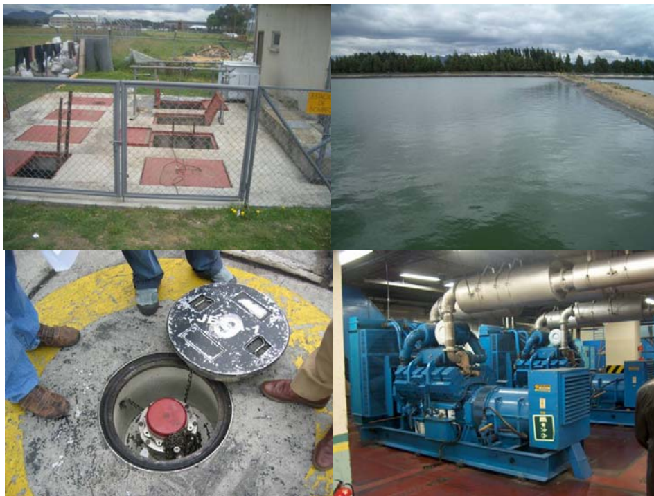
Estación de bombeo de aguas cloacales (arriba .izq.), laguna facultativa de depuración (arriba der.), válvula de tanqueo de aeronaves (aba. izq.), generador diesel (aba. der.)
